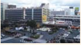
工事前の博多駅
